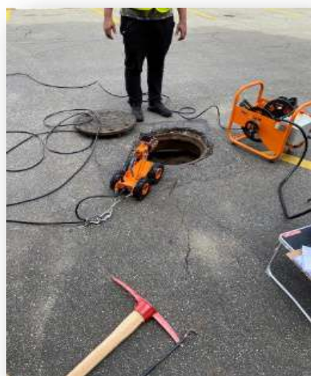
Utilização de “robô” para mapeamento do subsolo
