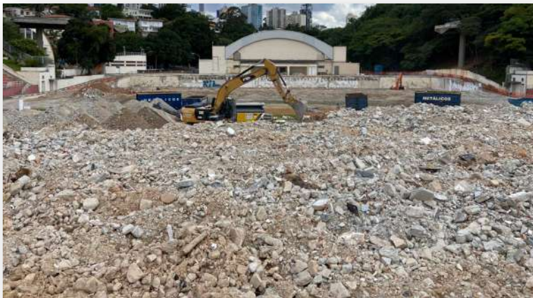
Britagem dos Resíduos – 30.11.2021 - Fonte: equipe Progen
