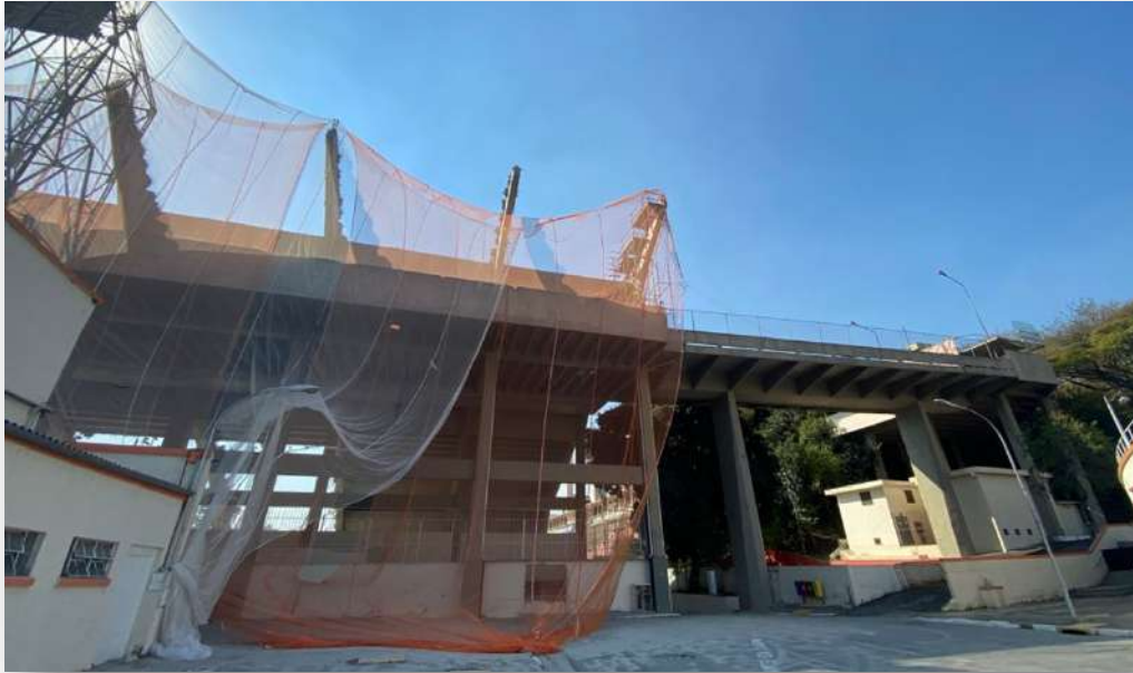
Demolição Tobogã (Arquibancada Sul) – 18.08.2021 Fonte: equipe Progen
