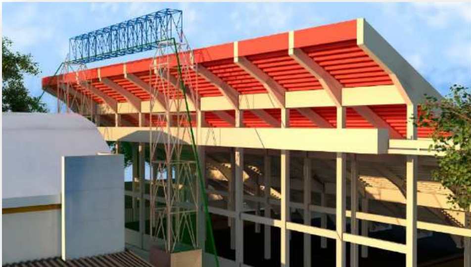
Demolição do Tobogã - 3ª Etapa: (Demolições Manuais da Arquibancada)
