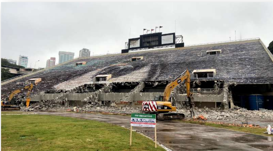
Demolição Tobogã (Arquibancada Sul) - Fonte: equipe Progen
