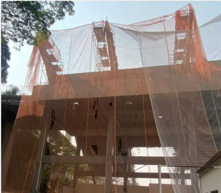
Demolição Arquibancada Sul (Tobogã) – 24.08.2021 Fonte: equipe Progen
