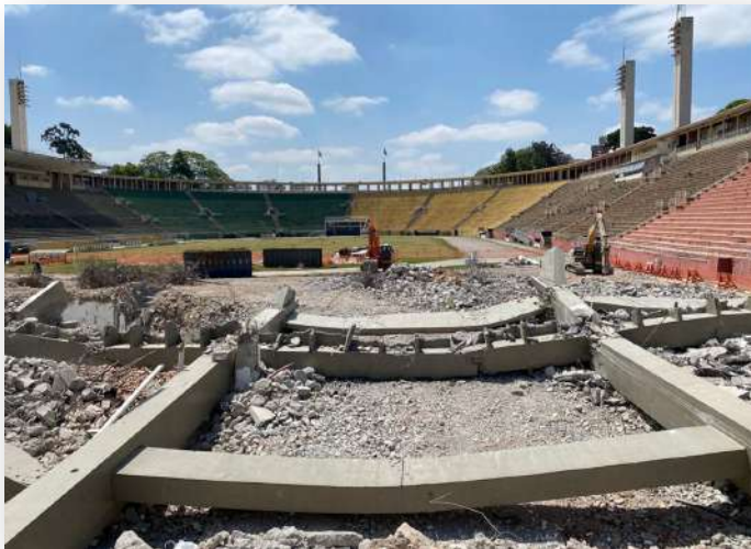
Demolição vigas e pilares da Arquibancada Sul (Tobogã) – 08.10.2021 - Fonte: equipe Progen
