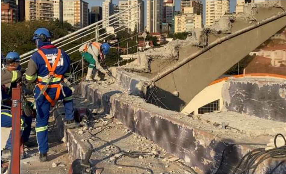
Demolição Arquibancada Sul (Tobogã) – 15.07.2021 - Fonte: equipe Progen
