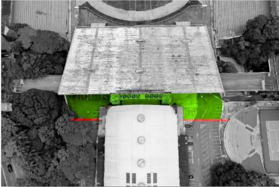
Demolição do Tobogã - 2ª Etapa: Instalação de Proteções
