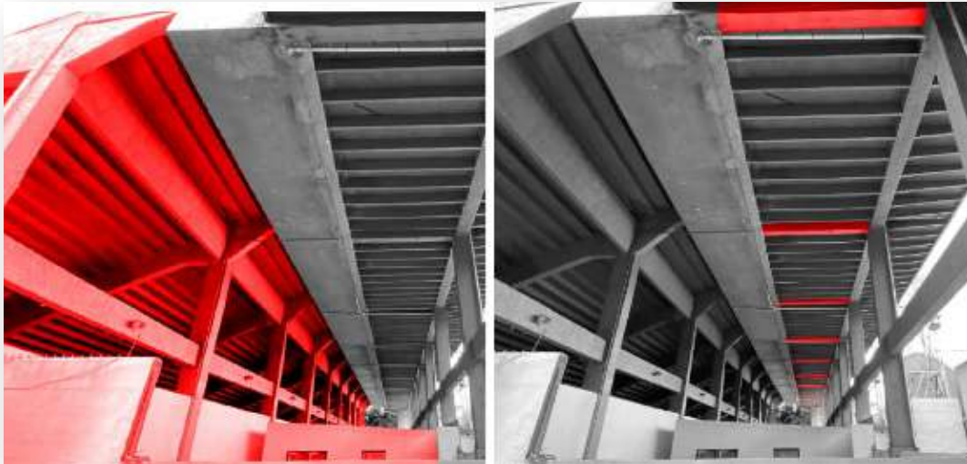
Demolição Arquibancada Sul (Tobogã) – 17.09.2021 - Fonte: equipe Progen
